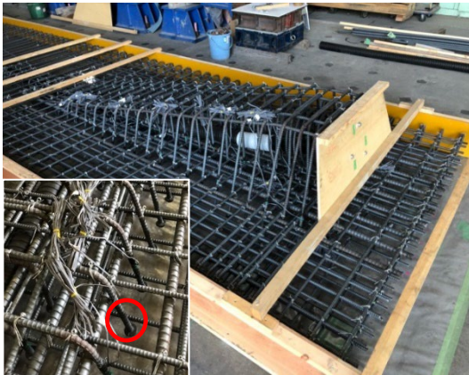
Trunc-head 配筋状況
