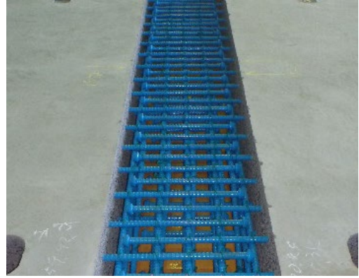
Trunc-head 継手配筋状況 (コンクリート打設前)
