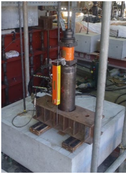
引抜き試験状況
